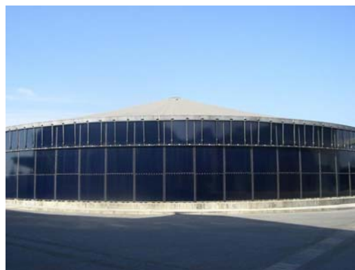
液肥貯蔵施設
