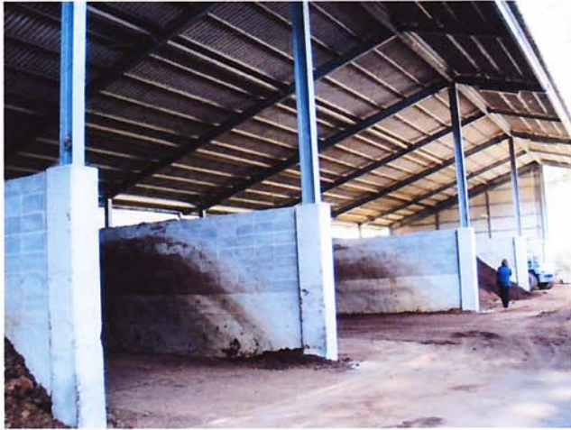
【堆肥生産施設】
