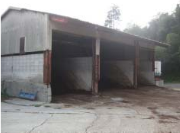
堆肥舎（通気あり） 92.12㎡
