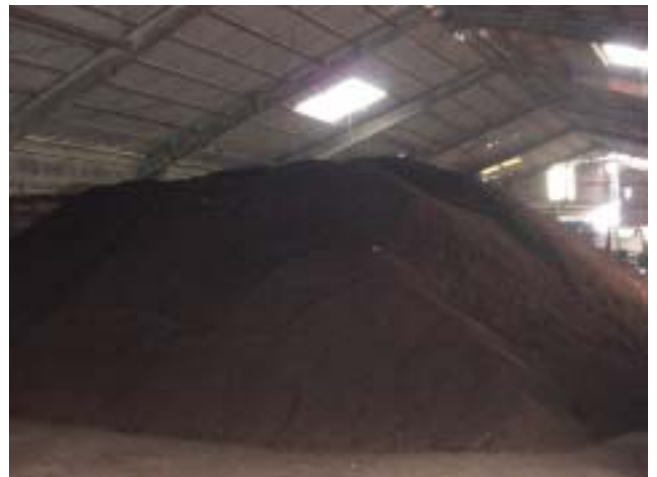
堆肥舎（ストックヤード） 504.0㎡
