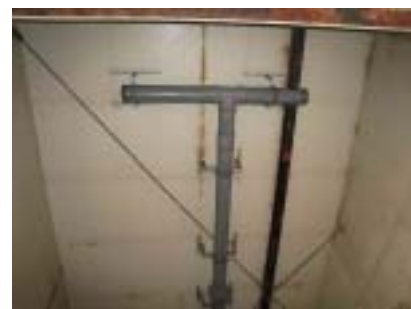
発酵槽天井 (天井から悪臭を吸引)
