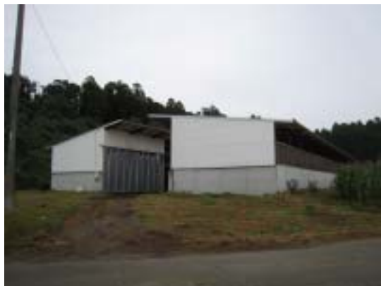
堆肥化施設全景
