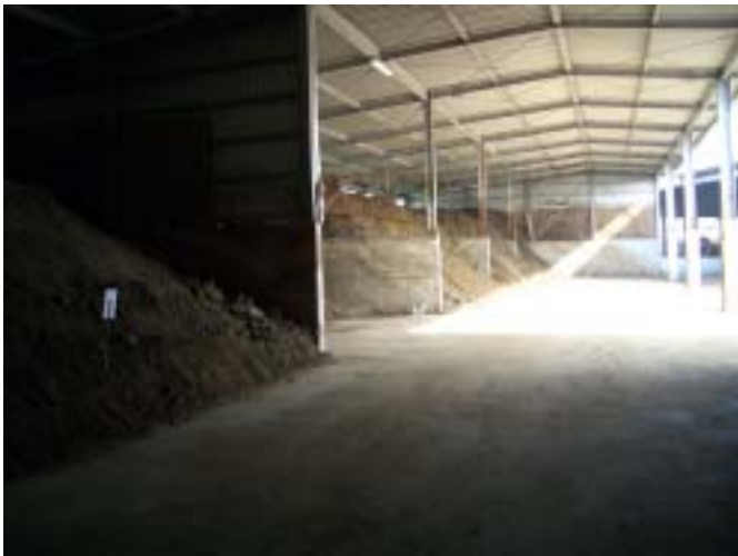
発酵槽の状況
